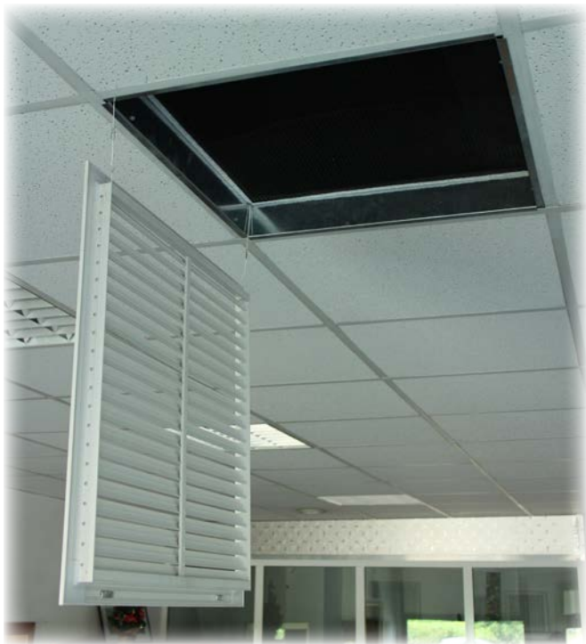
PARTICOLARE DEL FISSAGGIO GRIGLIA ISPEZIONABILE GTF
