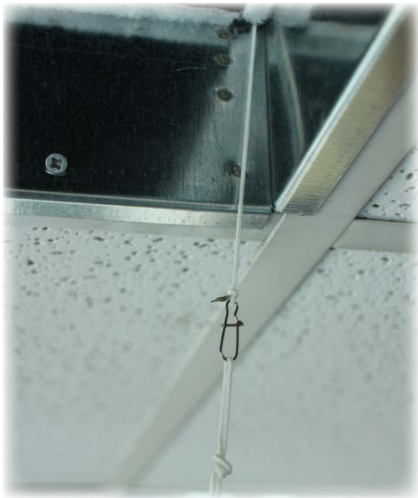
PARTICOLARE DEL FISSAGGIO GRIGLIA ISPEZIONABILE GTF
