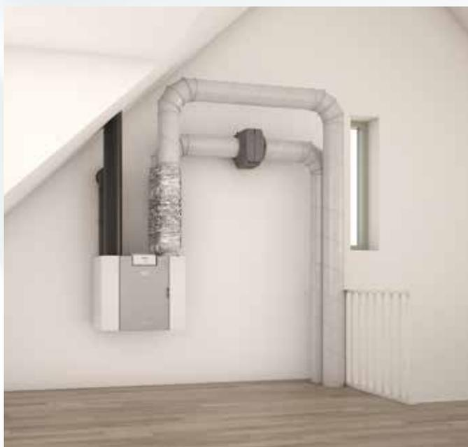
Dopo aver installato Evap nel condotto dell'immissione aria sana alle stanze, esso farà parte del sistema VMC.
